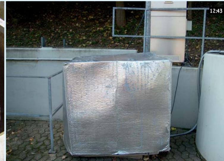
DOSFOLAT-Dosierbehälter (frostgeschützt) und -pumpe neben Verteilerbauwerk
