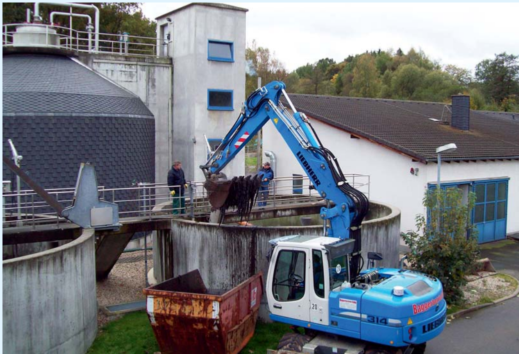
Räumung des ausgetragenen Materials aus dem Nacheindicker
