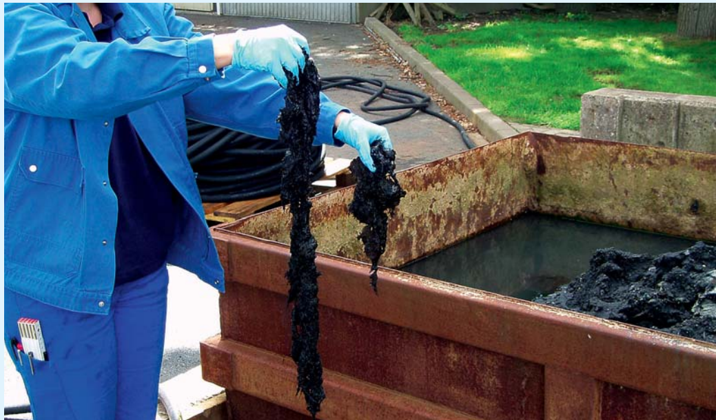
Durch enzymatische Hydrolyse ausgetragene Verzapfungen
